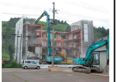
浦佐屋旅館解体工事 他多数
