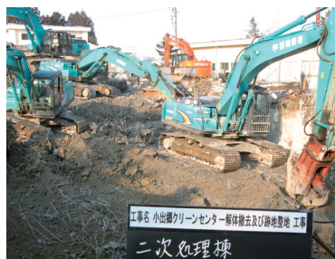
小出郷クリーンセンター解体工事
