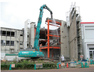
南魚沼市消防本部解体工事
