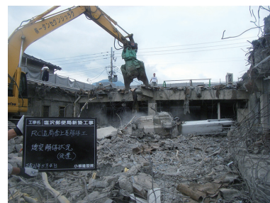
塩沢郵便局解体工事
